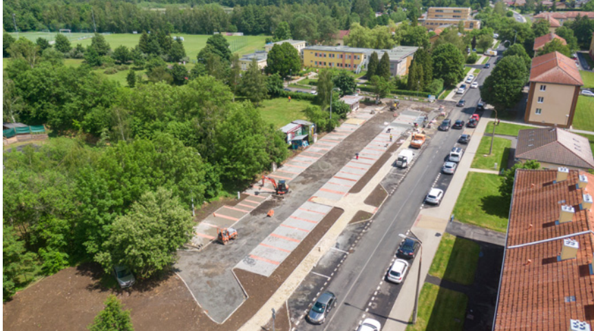
Součástí stavby bude také chodník z betonové zámkové dlažby, podzemní kontejnery na tříděný odpad a nové veřejné osvětlení. Foto: Petr Jakubes
