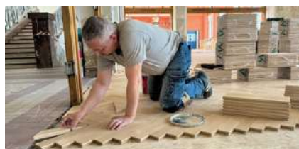
V červnu nastoupili na první patro budovy podlaháři. Nové parkety pokládali na bezmála pěti stech metrech čtverečních. Foto: Lucie Kubešová
