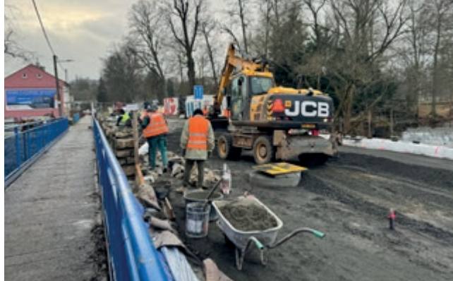
Stavba mostu je financována z prostředků Státního fondu dopravní infrastruktury a celkové náklady se odhadují minimálně na 18 milionů korun. Původně měla být hotová už na konci listopadu, foto: kub
