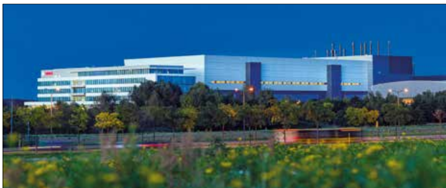
Bosch Dresden – Nejmodernější továrna na vývoj a výrobu polovodičů a čipů pro průmysl (výška zvýšené části 35 m) v Drážďanech
