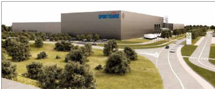
Sportisimo - Technologicky vyspělý sklad na ostravském brownfieldu v rámci městské zástavby – dokončení červenec 2022 (světlá výška zvýšené části haly High Bay - 23 m)
