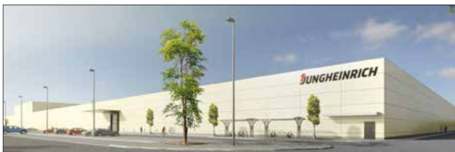
Jungheinrich Chomutov – nejmodernější továrna na vysokozdvizné vozíky na světě – zvýšená část budovy 18,4 m, zahájení provozu 2023
