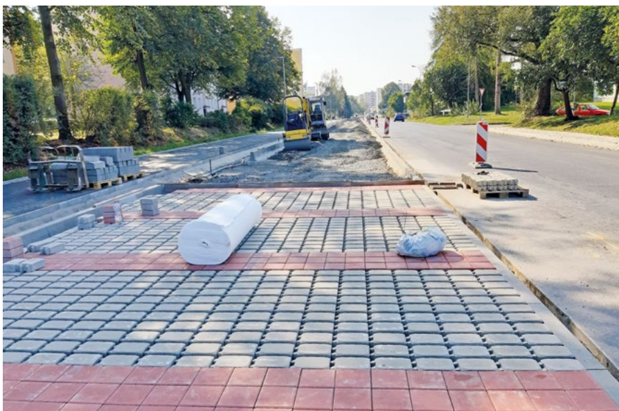
V ulici Jáchymovská zanedlouho vznikne 130 parkovacích míst.
