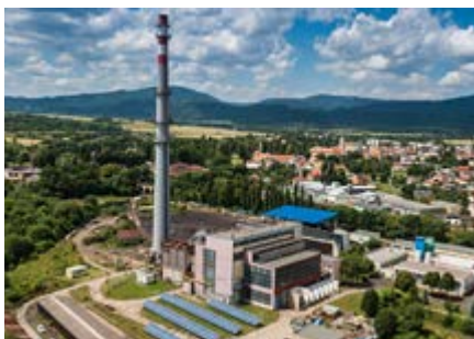
Foto: Ostrovská teplárenská a.s.
