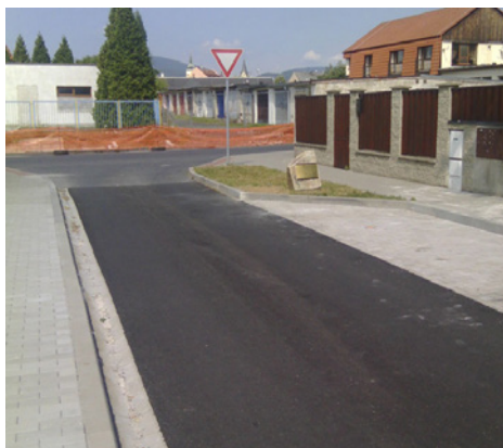
Rekonstrukce v Nejedlého ulici Foto: Archiv MěÚ Ostrov
