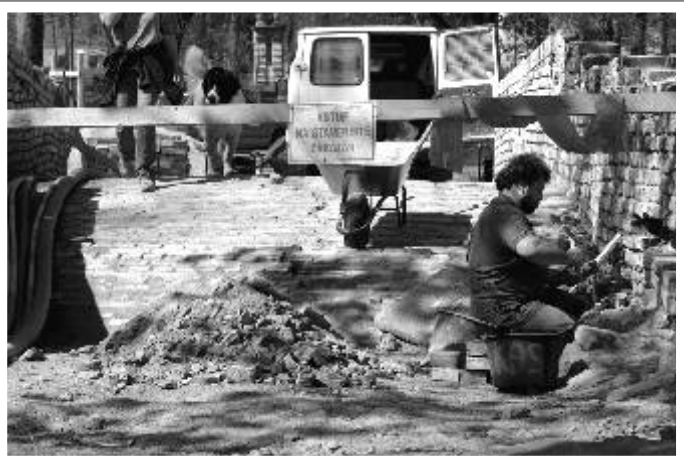
Oprava mostku. Foto: Vladimír Toman
