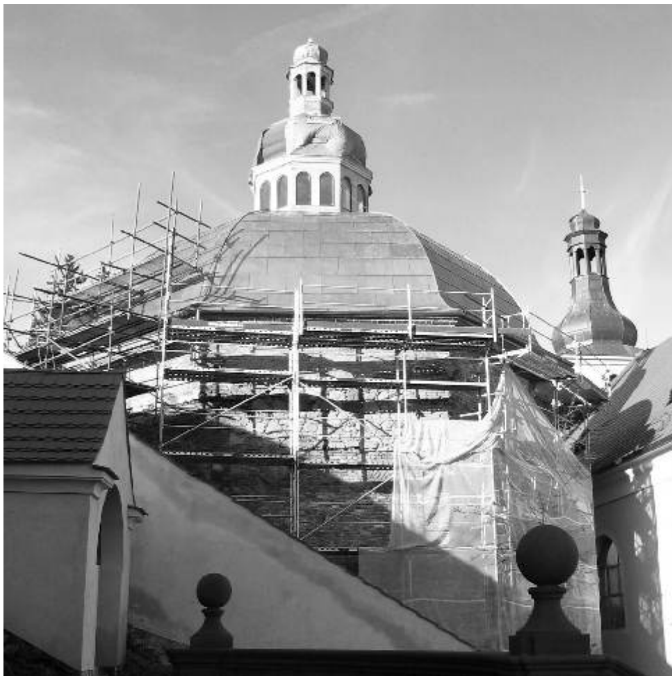
Kaple sv. Anny, která je v rekonstrukci, dostává novou kupoli.
