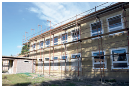
Foto archiv OM Rekonstrukce Domova pokojného stáří – 2016
