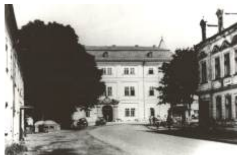
Foto: Celkový pohled na zámek (vlevo s betonovým bunkrem)
