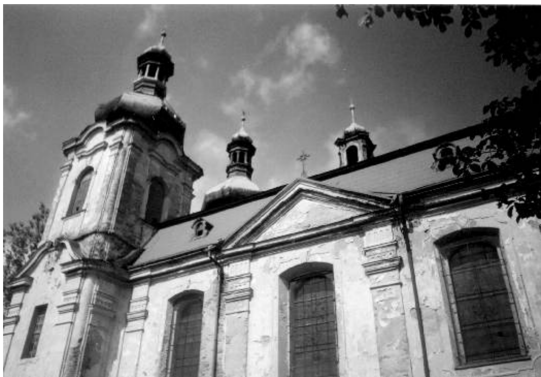
Měděná střecha kupole ve Skočich je v současnosti už zcela rozebraná zloději.
